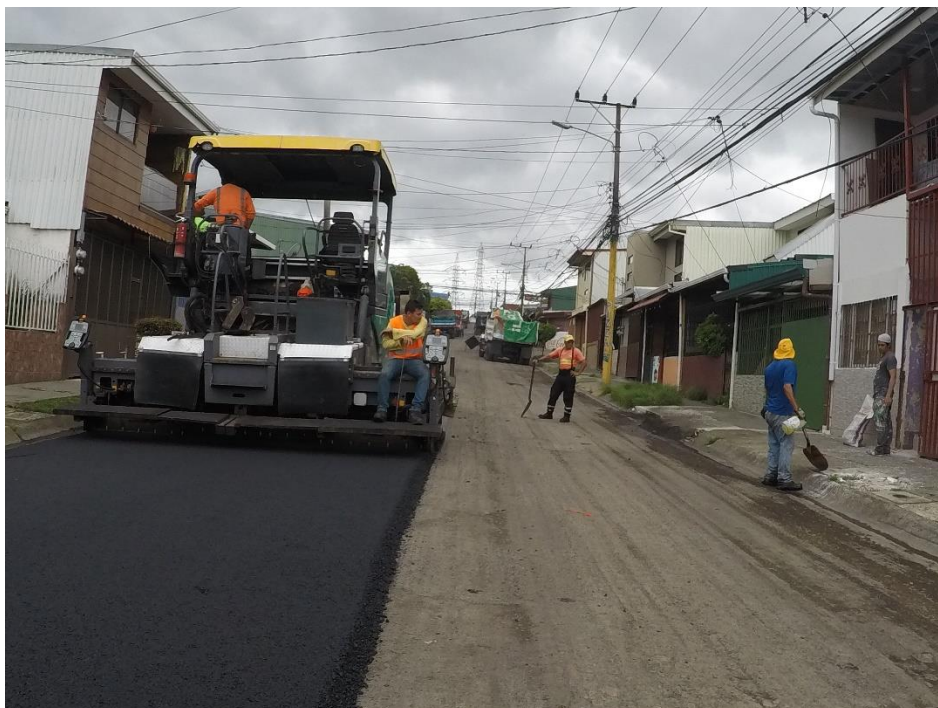
Imagen 2: Asfaltado en Korobó.
