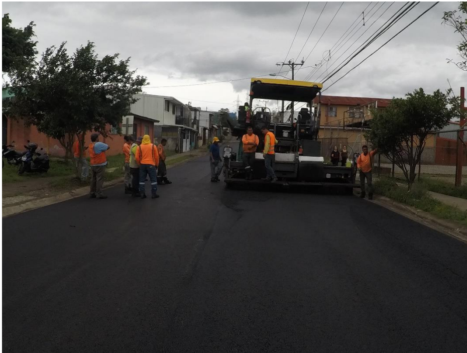
Imagen 1: Asfaltado en Korobó.
