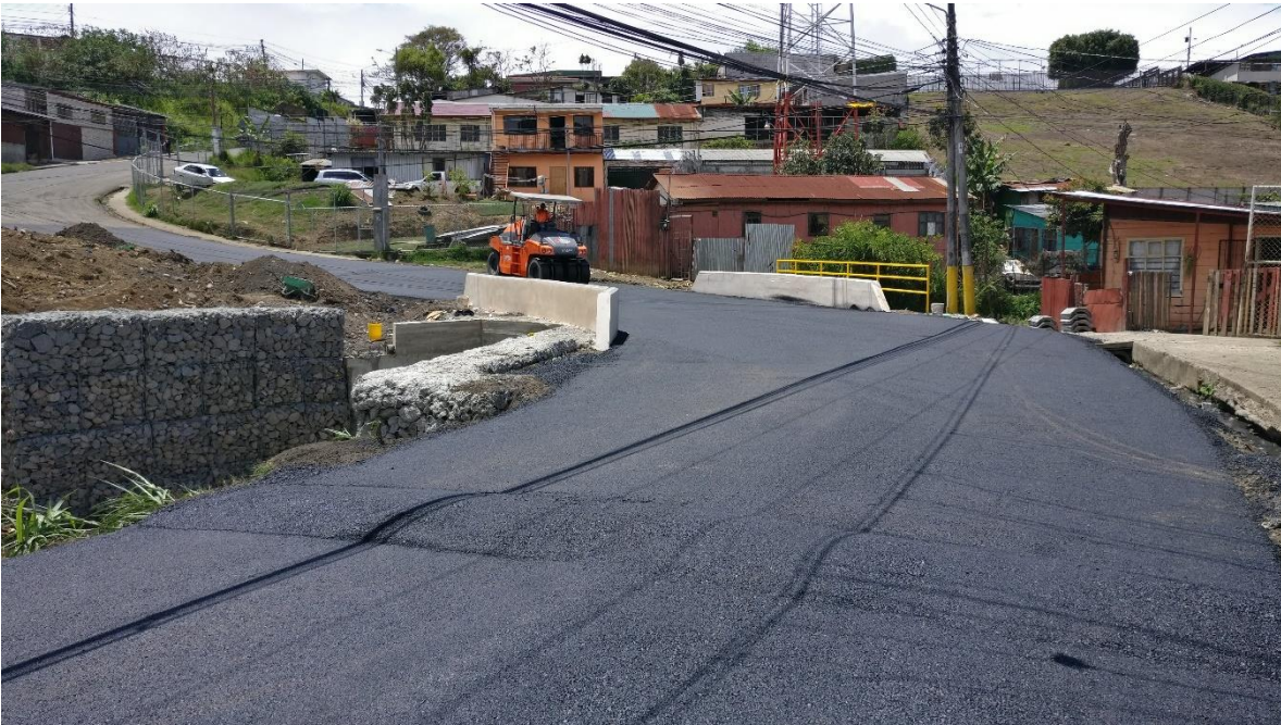
Imagen 5: Alcantarillado en el sector de La Nena, distrito de Purral.
