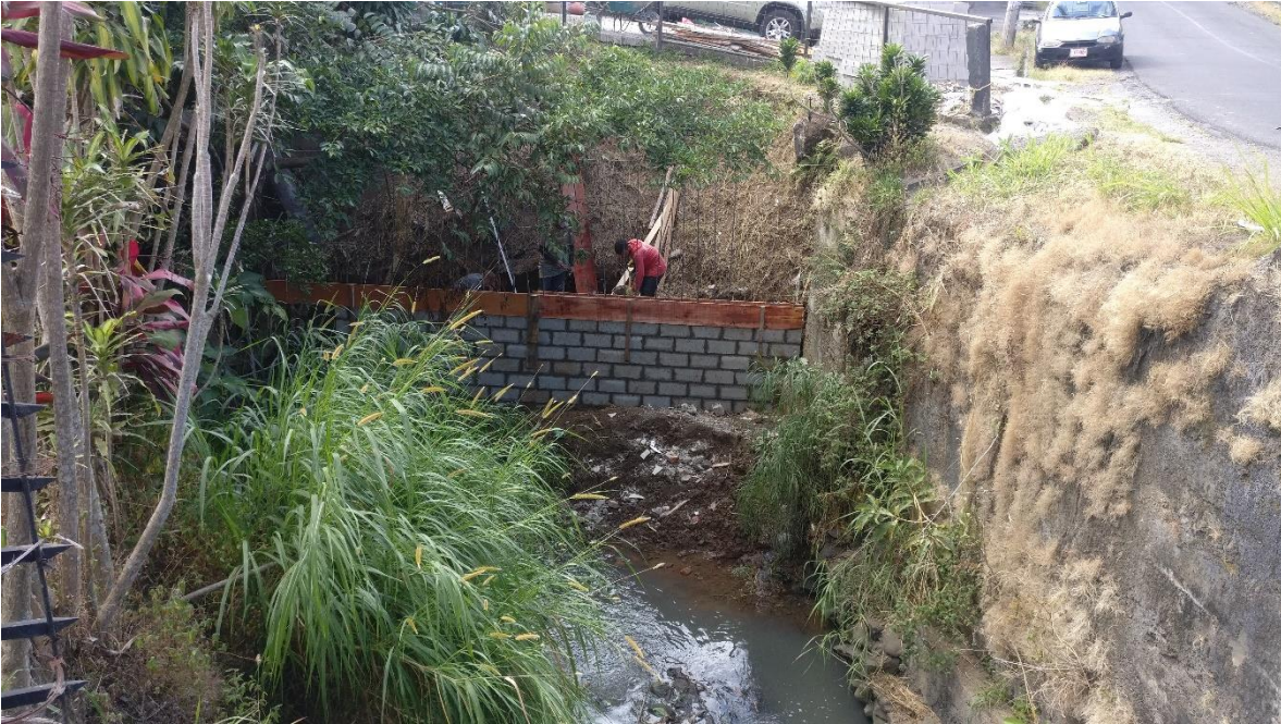
Imagen 9: Muro de puente peatonal.
