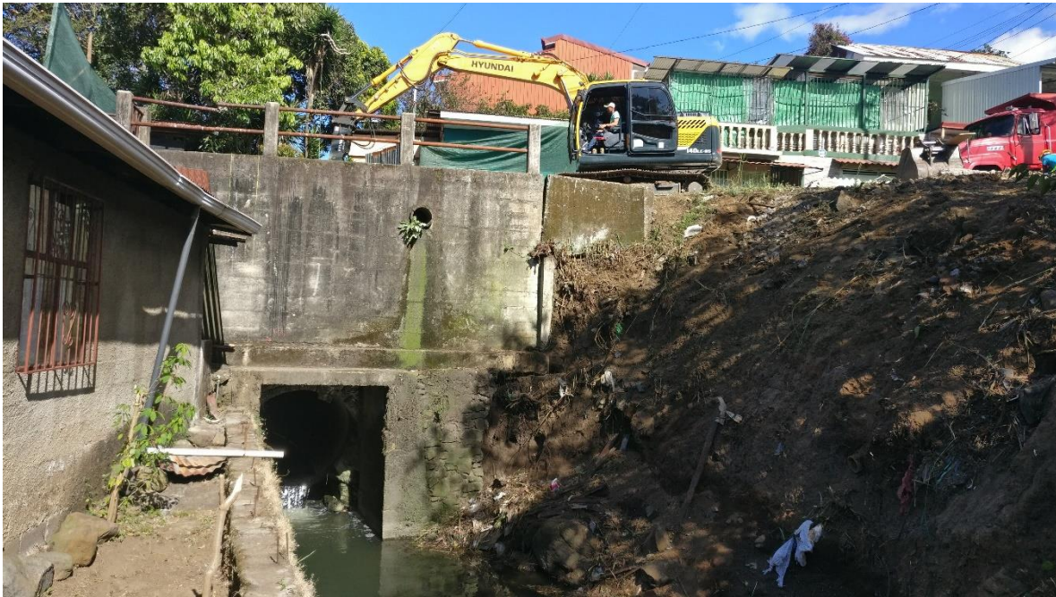
Imagen 6: Demolición de la estructura existente.
