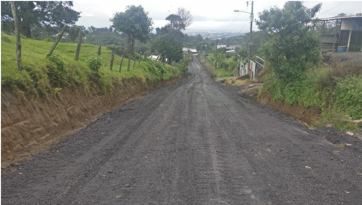
Imagen 4: Después de los trabajos.
