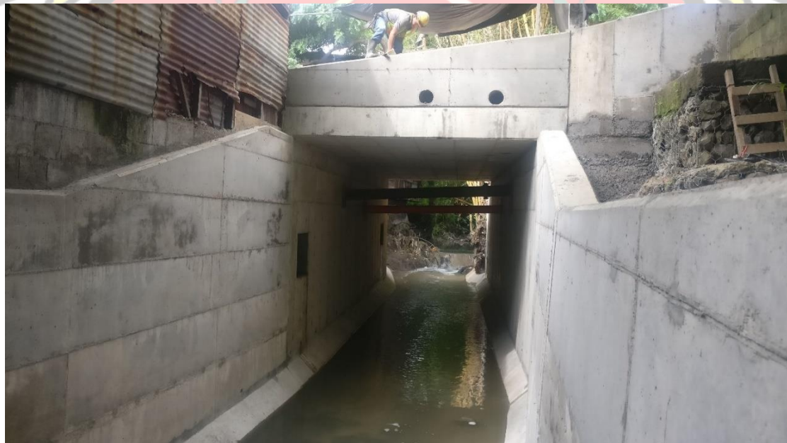
Imagen 11: alcantarilla 2 en límite entre Calle Blancos y San Francisco
