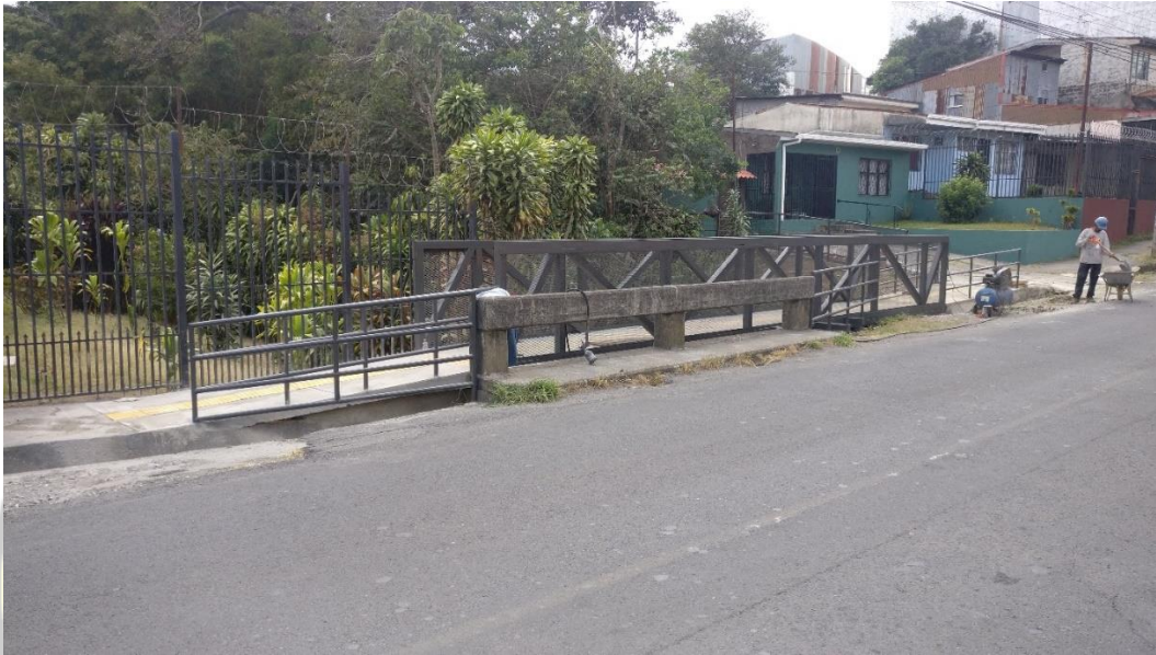
Imagen 12: Puente peatonal en río Ipís.
