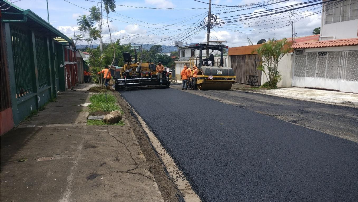
Imagen 2: Asfaltado en Las Magnolias.
