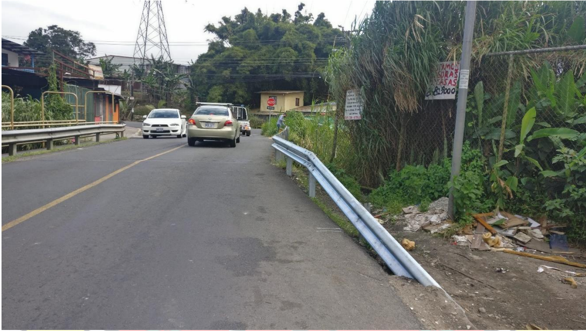
Imagen 14: Colocación de baranda Flex beam en Purral abajo.
