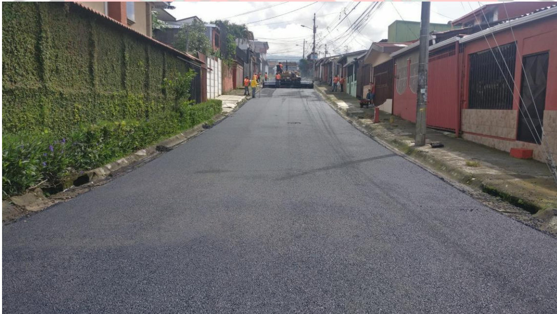
Imagen 5: asfaltado en Calle Zetillal.
