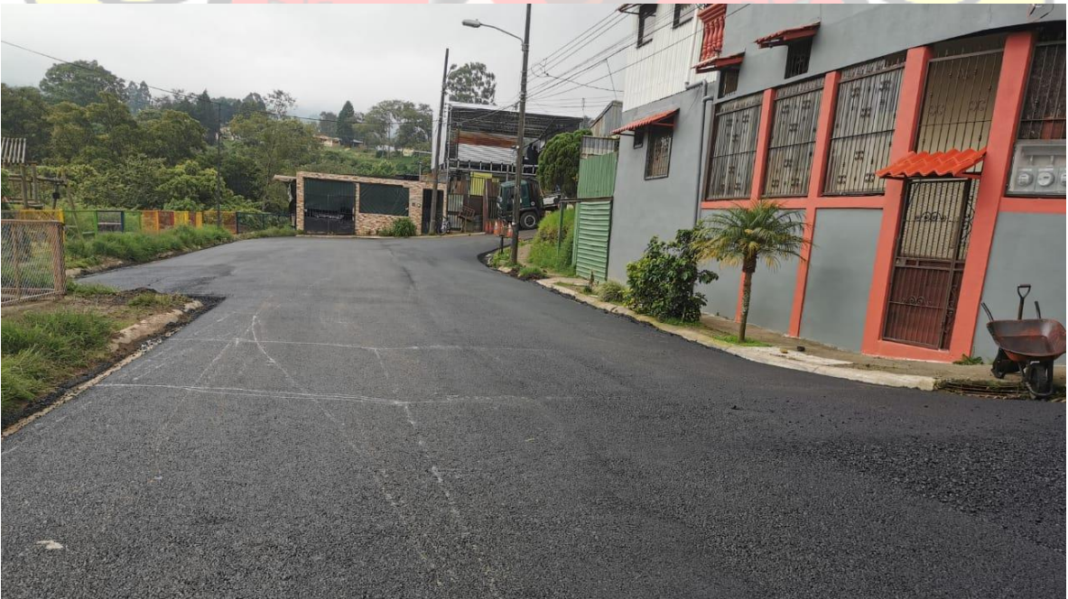
Imagen 3: asfaltado en Vista De Mar.
