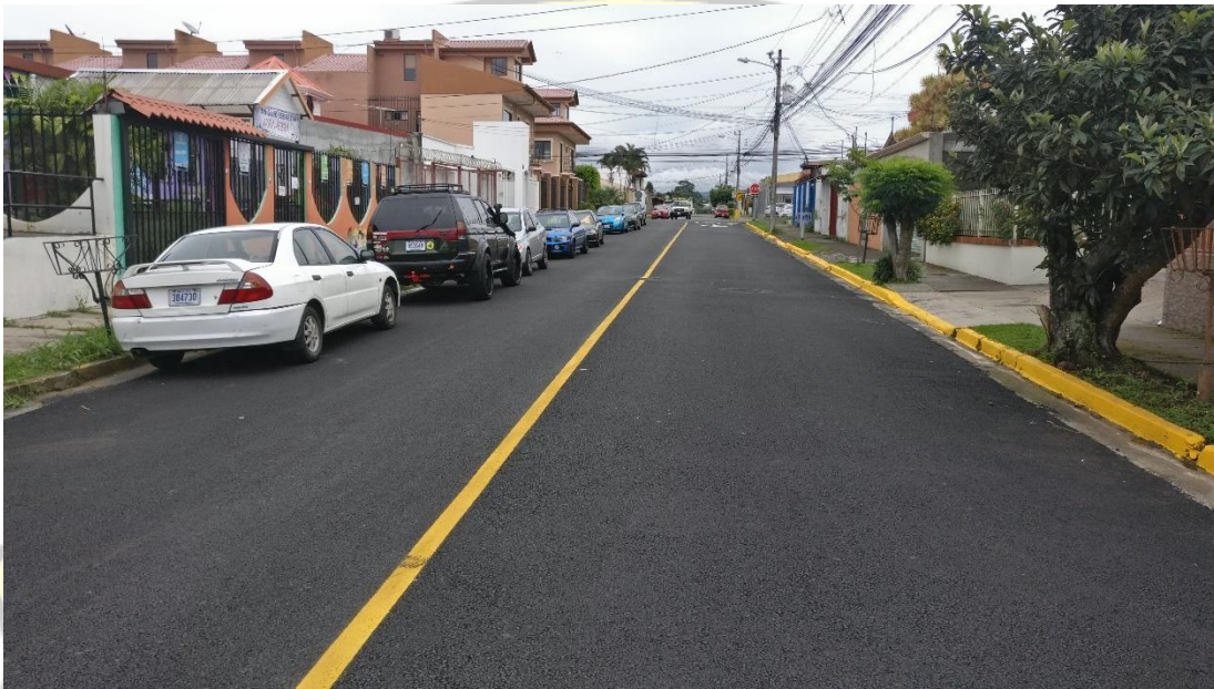
Imagen 1: asfaltado en Calle Blancos, Montelimar.
