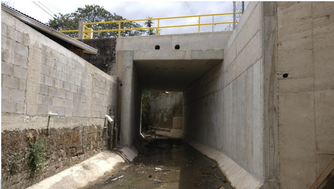
Imagen 10: alcantarilla 1 en límite entre Calle Blancos y San Francisco
