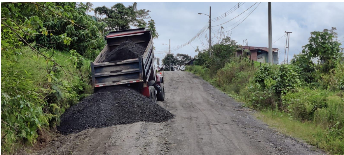
Imagen 9: colocación del material de perfilado en la ruta.
