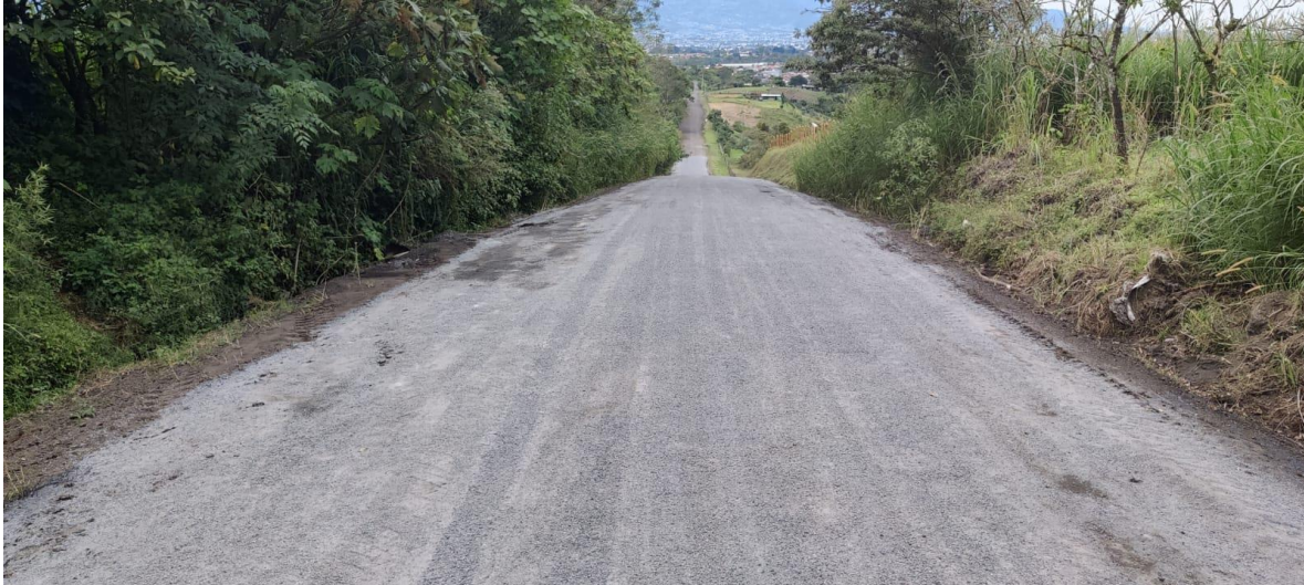
Imagen 8: colocación del polvo de piedra encima de la capa de perfilado previamente imprimada con emulsión asfáltica.
