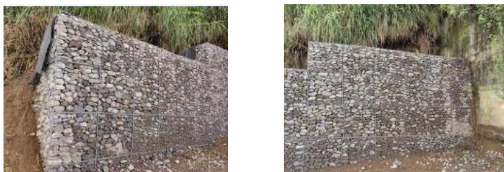
Construcción de muro de gaviones ADIMAPLA, dist. De Mata de plátano
