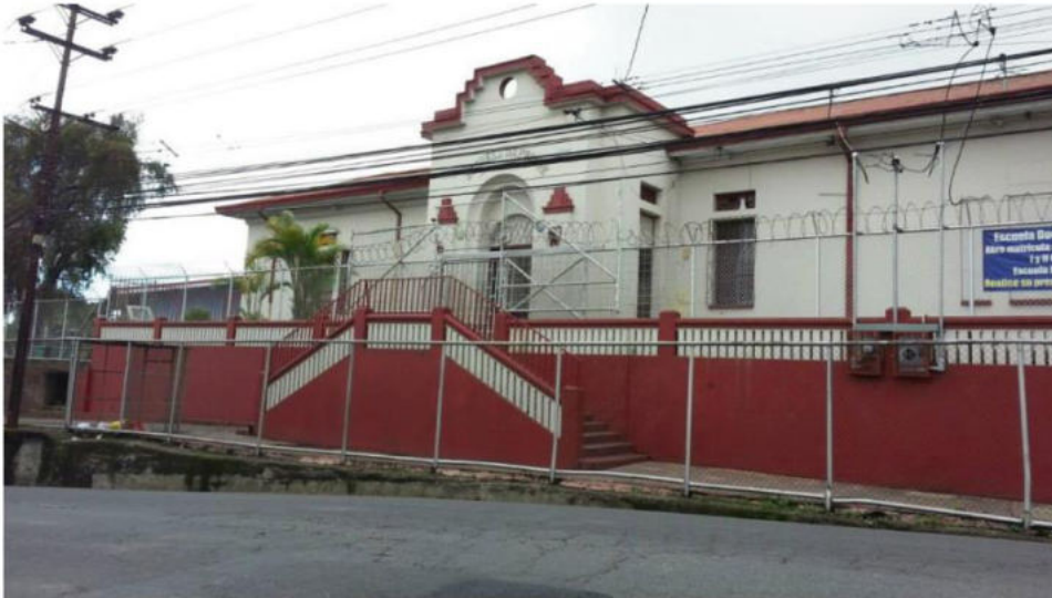
Inmueble Escuela Dr. Ferraz Época 1932 - 1936 Distrito Calle Blancos Coordenadas Crtm05: 1.099.437 N - 492.582 E
