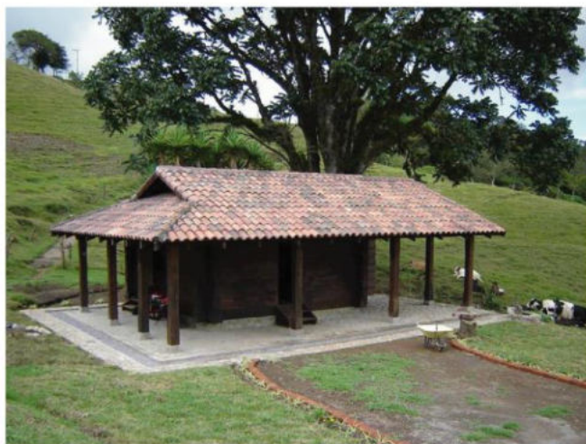
Inmueble Casona de Viguetas Época 1901-1950 Distrito Mata de Plátano Coordenadas Crtm05: 1.100.781 N - 502.389 E
