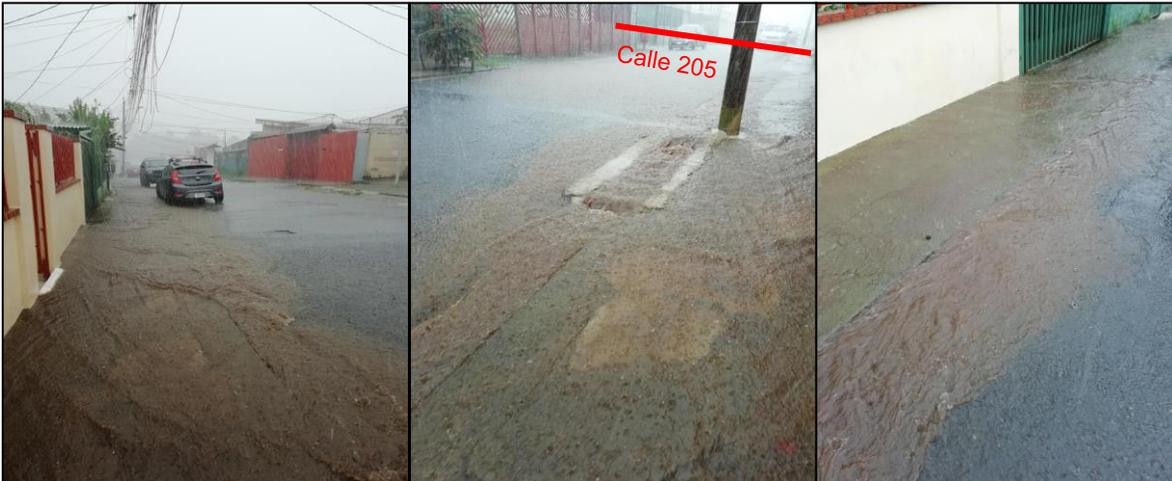
**Figura 4** Saturación de componentes del alcantarillado pluvia, Mata de Plátano
