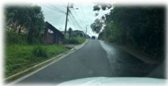
Construccion de cordon de caño . Calle Vista de Mar-Jaboncillal. Rancho Redondo.
