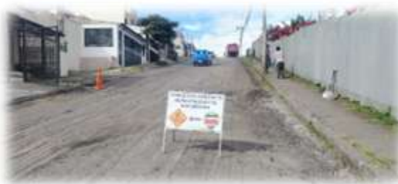
Proceso dePerfilado en Calle La Nueva. Mata de Platano.
