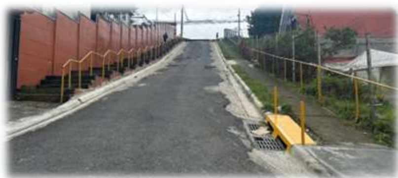
Construcción de cordón de caño Urbanización El Valle. Mata de Plátano.
