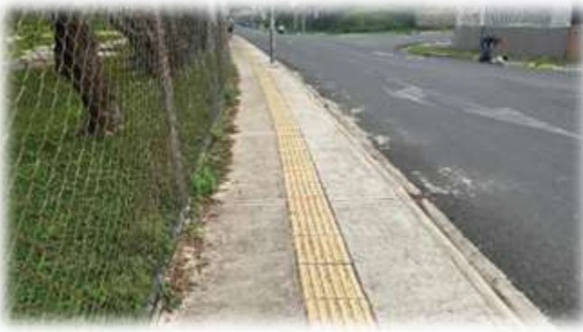
Construcción de acera y rampa en parque el Ocho. Mata de Platano
