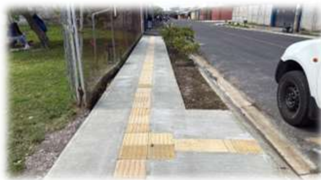
Construccion de acera y rampa Urbanizacion Korobo. Ipis
