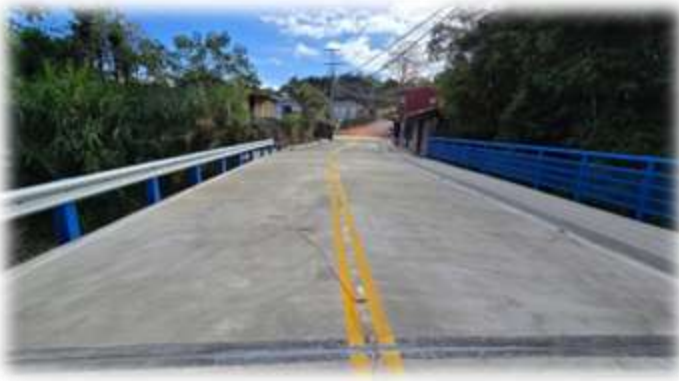
Construccion de Puente sobre Rio Torres. Paso Hondo. Guadalupe.
