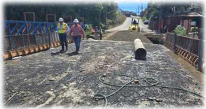
Construccion de Puente sobre Rio Ipis. Zetillal. Ipis.
