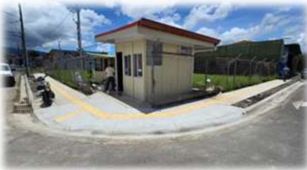
Construccion de acera y rampa en parque de la Urbanizacion Bernardo Iglesias. Mata de Platano.
