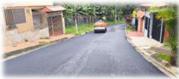
Proceso de asfaltado en Urbanización Prusia. Mata de Platano
