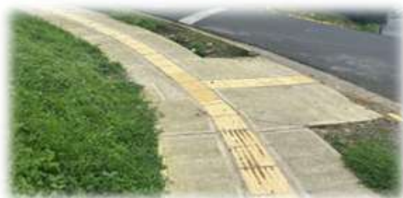
Construccion de acera y rampas en Urbanizacion La Esmeralda. Purral
